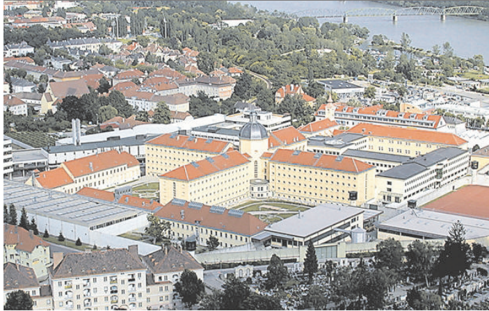
Die Justizanstalt Krems-Stein mit dem denkmalgeschützten Sterntrakt steht auf heiß begehrtm Grund. Foto: Lechner
